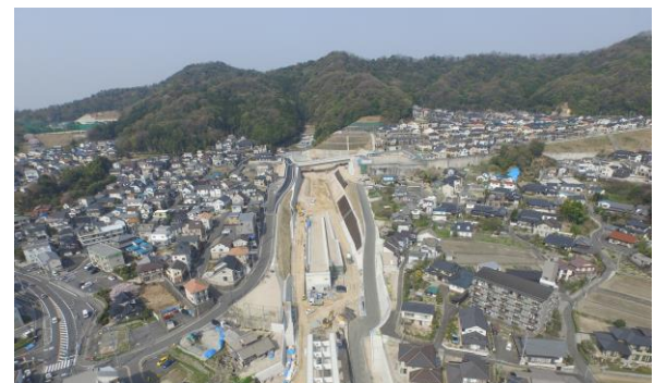
（写真-2）NATMトンネル区間 中山地区坑口付近
