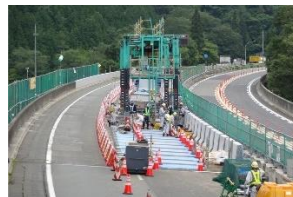
半断面床版取替試験施工状況
