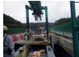
半断面床版取替試験施工状況
