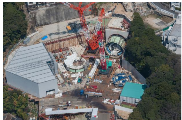
（写真-1）シールドトンネル区間 二葉の里地区坑口付近
