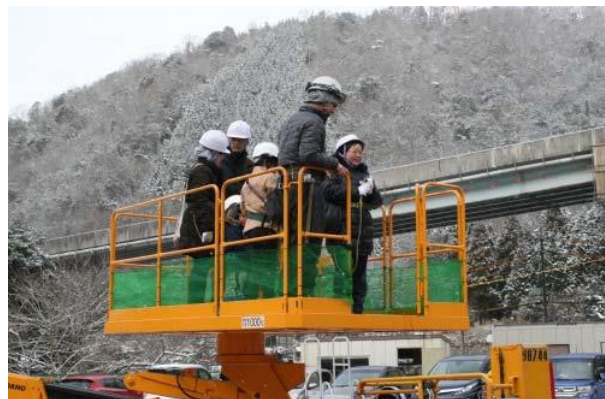
写真3 親子が参加した「橋の点検・工事体験会」
