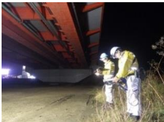
写真1 赤外線調査トータルサポートシステム（平成29年度試行）
