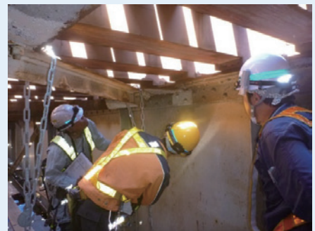
橋梁の検査状況
