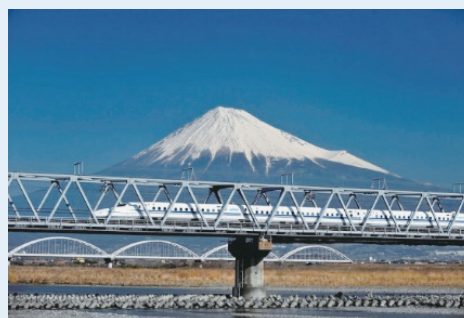
東海道新幹線 富士川橋梁 (東海道新幹線より溶接構造を全面的に採用)
