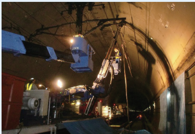
終列車～初列車の時間帯でのトンネル補強状況 (ロックボルト打設)
