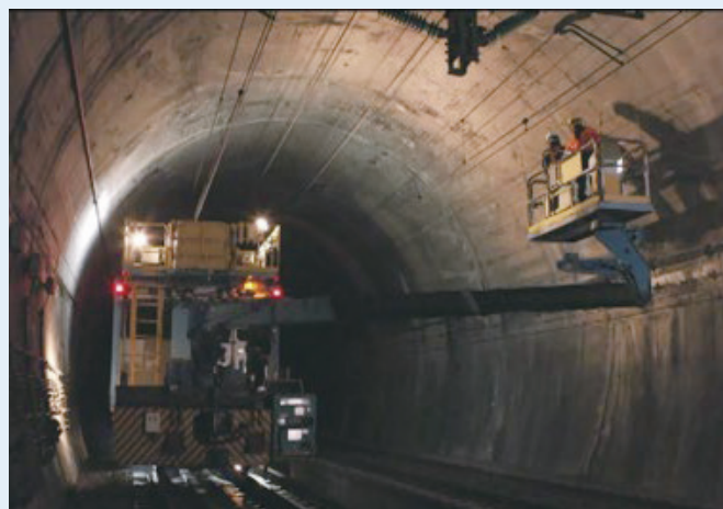
レールの上を移動できる機械で、作業台が上昇します。トンネル表面を至近距離で検査します。
