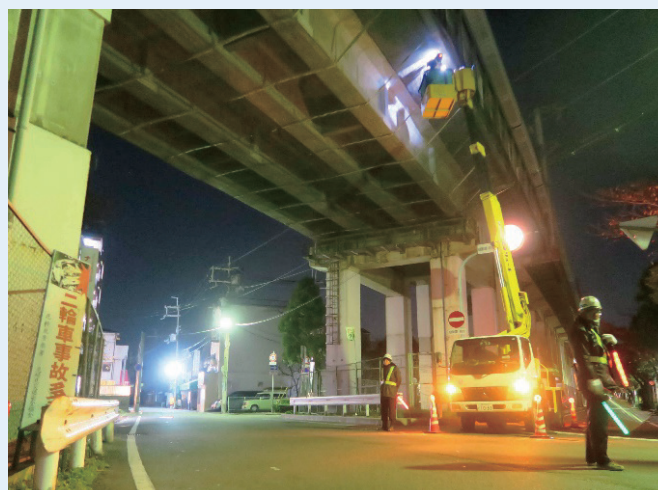
高所作業車を使い至近距離で橋梁の検査を行っている様子です。
