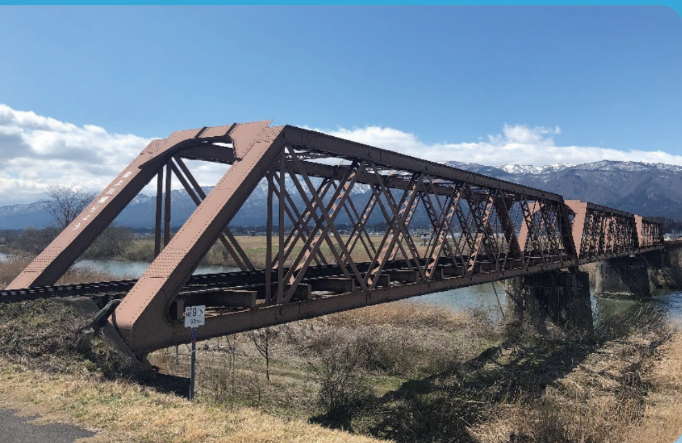
山形鉄道 フラワー長井線 最上川橋梁 日本最古の現役鉄道橋梁 1886年桁製作、経年134年 (平成20年度選奨土木遺産)
