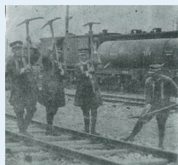
ビータによるバラスト突き固め
