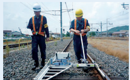
軌道の検査状況
