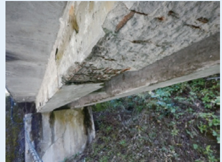
コンクリート橋梁の凍害・鉄筋腐食の事例
