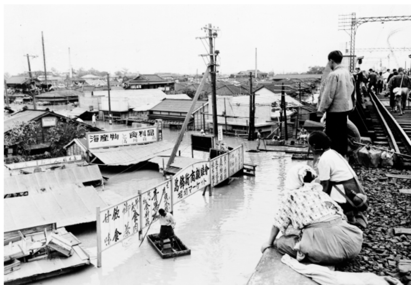
(写真提供) 国土交通省関東地方整備局 利根川上流河川事務所 「葛飾区堀切付近の高架線路上に避難する人々」
