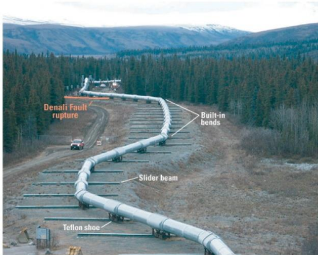
写真1 アラスカ横断石油パイプラインの活断層対策
