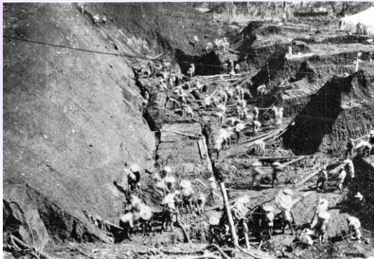
トンネル坑口の崩壊 (土木学会HPより) (中央本線 與瀬トンネル)
