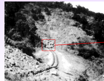
斜面崩壊によるトンネル崩壊 (土木学会HPより) (熱海線 寒ノ目トンネル)
