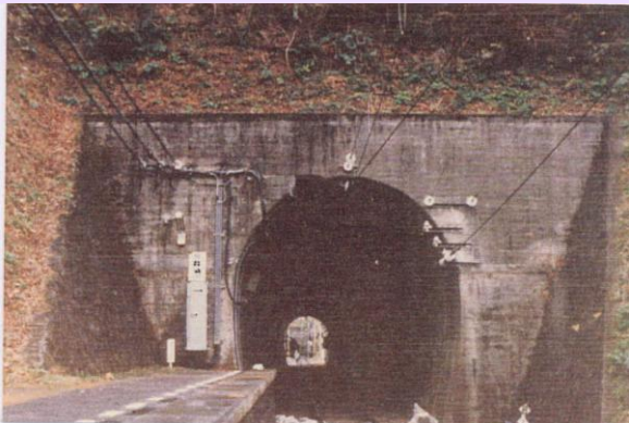
坑門の目違い亀裂と打継目部からの欠落 (伊豆急行 今井浜トンネル)
