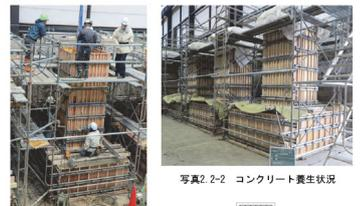
写真2.2-2 コンクリート養生状況
