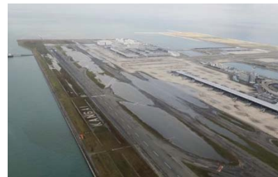
台風21号の影響で浸水する 関西国際空港 (写真出典:時事通信)
