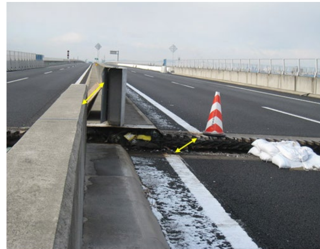
仙台東部道路の橋梁ジョイント損傷
