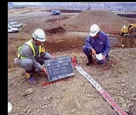
施工延長200mにつき1ヶ所検査
