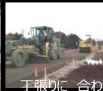
丁張りに 合わせ施工
