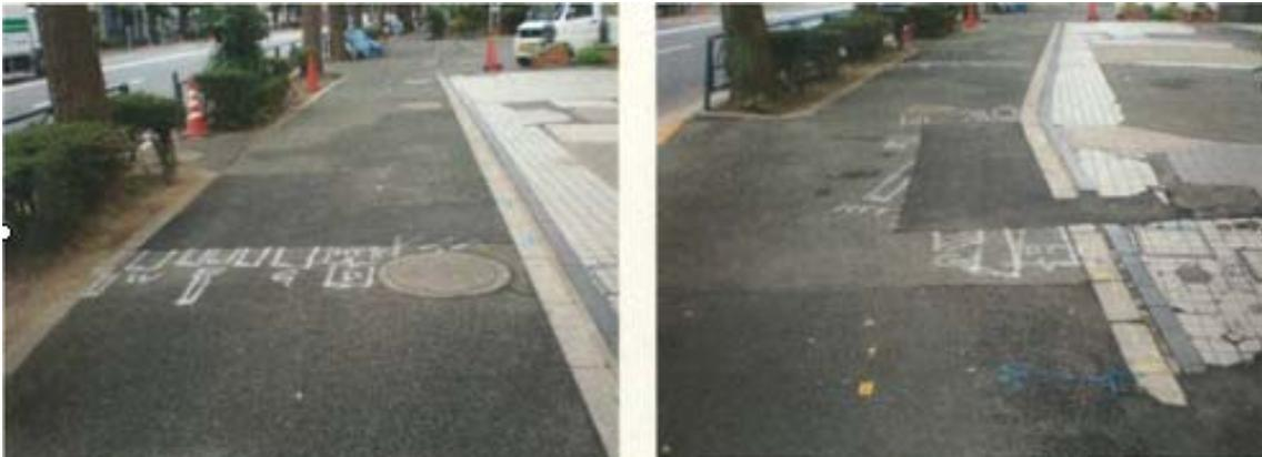
図 2-27 渋谷区某所における埋設管路試掘跡(2011-07-01 撮影)
