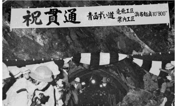
写真 3-1 青函トンネル 貫通
