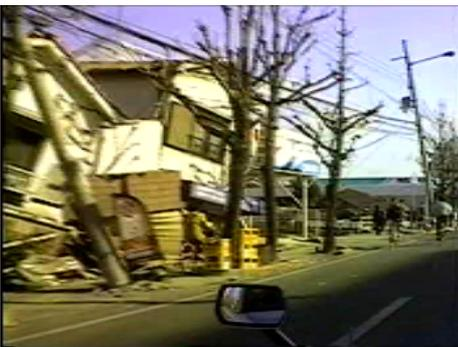
写真-14 同じ方向に倒れる電柱(東灘区)※
