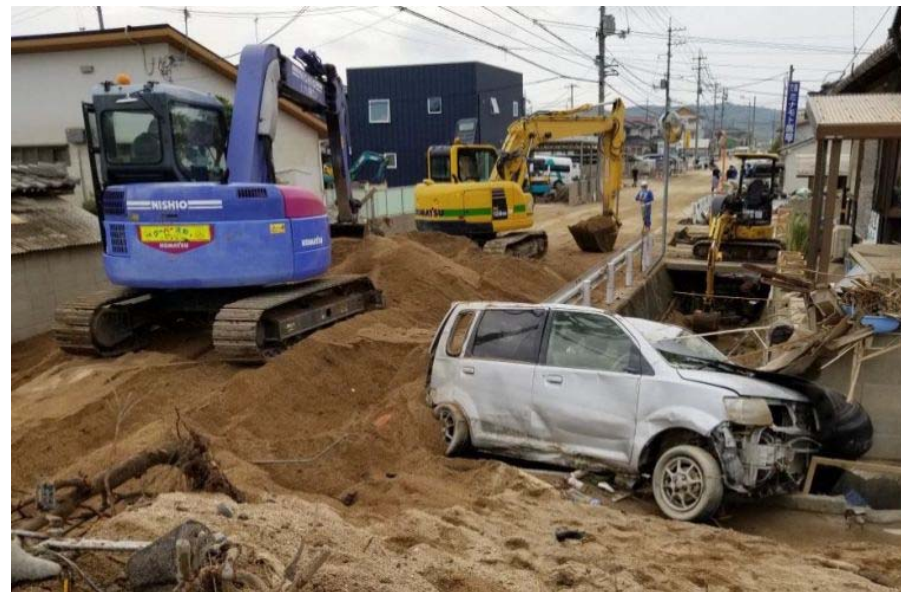
道路上の土砂や被災車両を撤去
