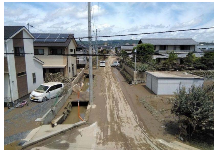
土砂に覆われた住宅地や道路
