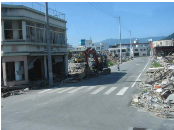
ガレキの撤去が進められている
