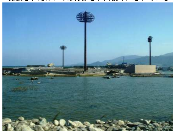
地盤沈降により浮島ようになった市営松原球場
