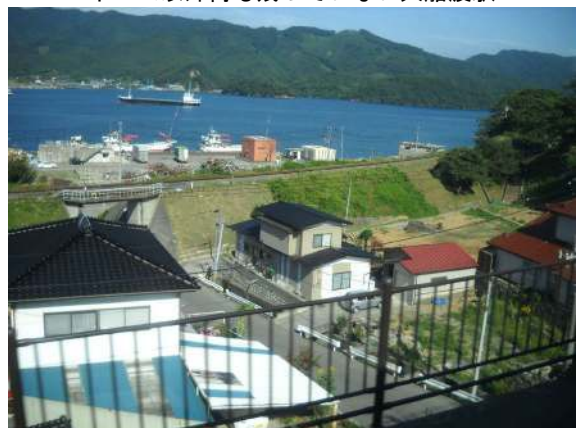
鉄道盛土の背後は目立った被災なし
