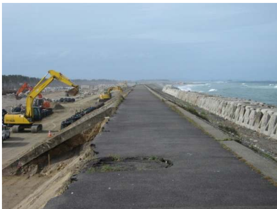
応急復旧が進められている直轄海岸
