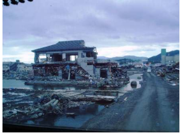
排水が進まないためガレキの撤去も停滞
