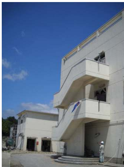
市庁舎3階まで津波到達、屋上に行けない外階段
