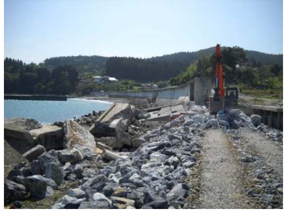
破壊された防潮堤の応急復旧状況
