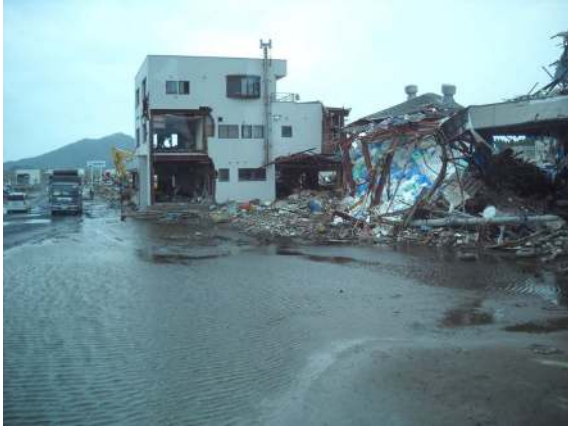
構造的な地盤沈降により海水が湛水
