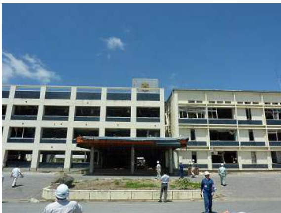
津波により市庁舎壊滅的な被害を受ける
