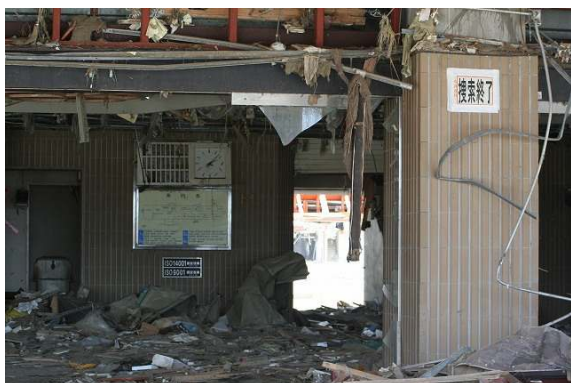
津波に被災した市庁舎1階の内部
