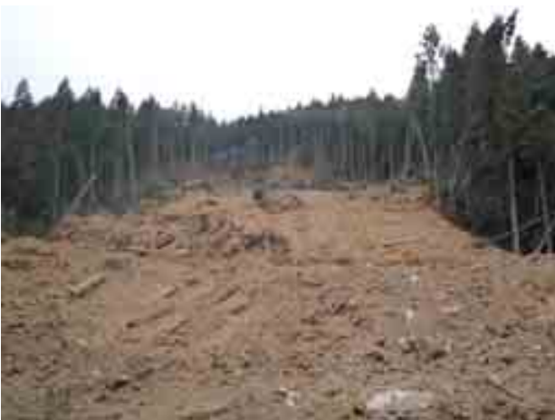
写真-13 白河市-県道58号線沿い(岡の内)の 斜面崩壊③
