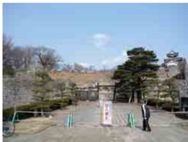
写真-2 小峰城の石垣崩落②
