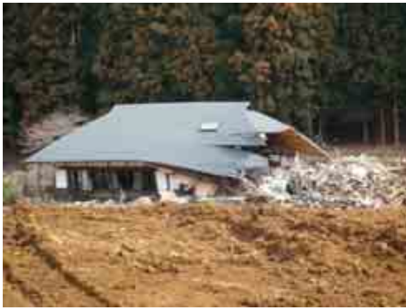
写真-5 葉の木平-崩壊土により一部破損した住宅③
