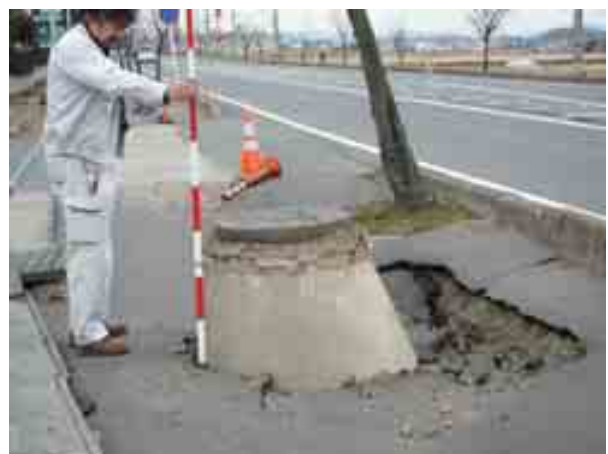
写真-9 南湖南の国道 289 号線沿いの歩道のマンホール浮き上がり①
