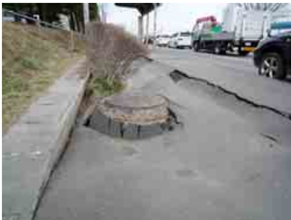
写真-8 南湖南の国道 289 号線沿いの歩道の下水管路部の沈下①
