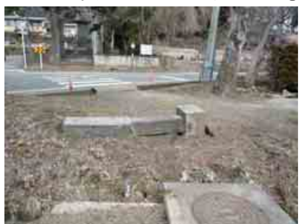
写真-11 南湖南の国道 294 号線沿いの新興住宅地における石柱の転倒②
