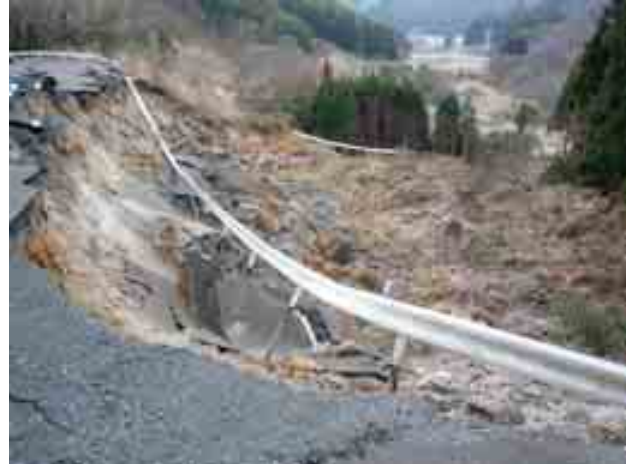
写真-14 白河市-県道58号線沿い(岡の内周辺) の周辺斜面崩壊
