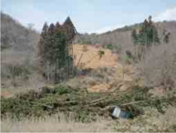
写真-13 白河市-294号線沿い(北の入周辺)の 斜面崩壊①
