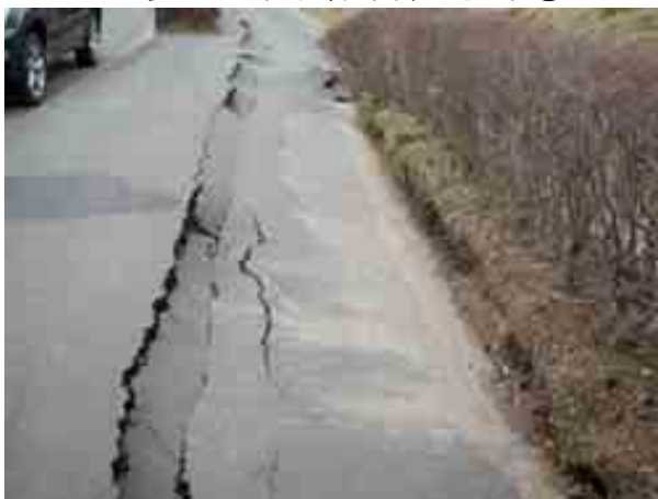
写真-10 南湖南の国道 289 号線沿いの歩道の噴砂跡①
