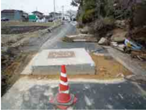
写真-12 南湖南の国道 294 号線沿いの新興住宅地における下水施設の浮き上がり②
