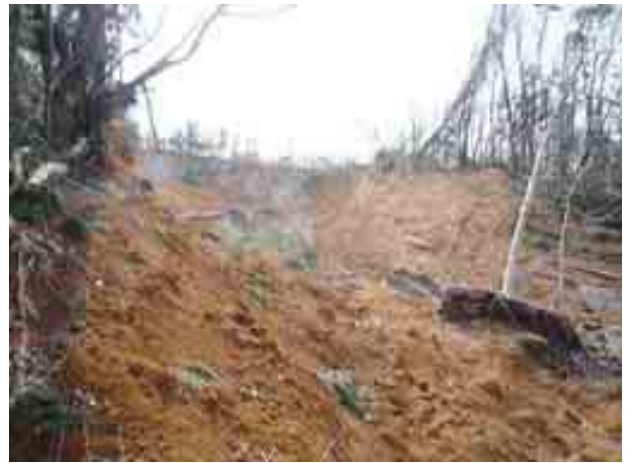
写真-14 白河市-294号線沿い(牛清水周辺) の斜面崩壊②
