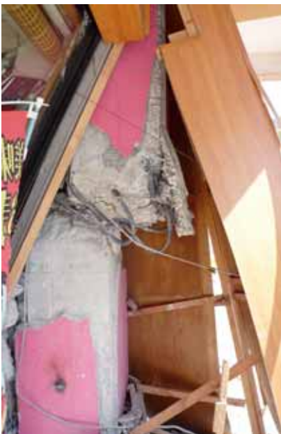
写真-4(2)④ 回転ずし店舗の崩壊 (RC柱のせん断破壊)
