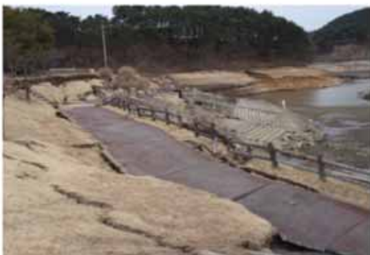
11 公園護岸の湖に向かったすべりとはらみだし
