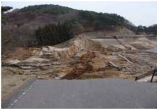
3 ダム左岸天端よりみた決壊した堤体
