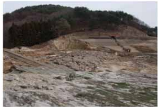
4 堤内側（左岸側）からみた堤体
