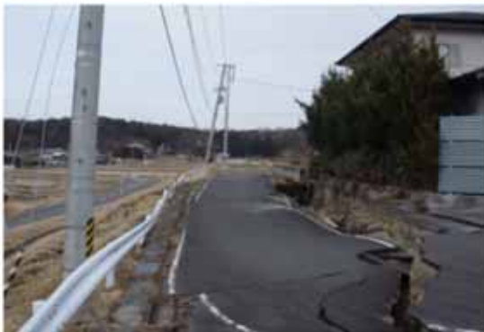
17 盛土天端の状況
