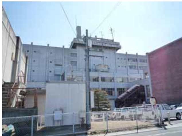
写真-5⑤ 市役所のペントハウスの2,3階の崩壊 中間の水槽タンクの崩壊(気象庁震度計とあわせて)
