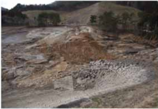
7 堤体右岸側から堤体を見た状況
