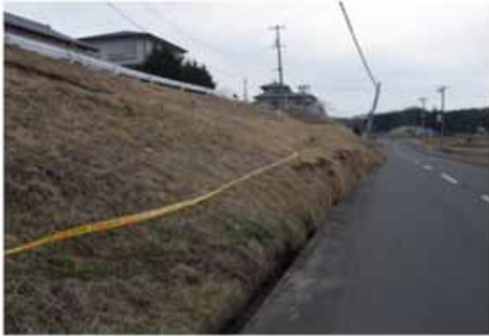
15 住宅団地の盛土のはらみだし
