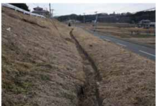
18 盛土のはらみだし
