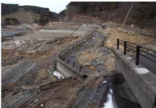
9 決壊しなかった箇所では被害が大きかった堤体の状況（堤内側）
