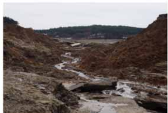
6 堤体からダム湖を見た状況
