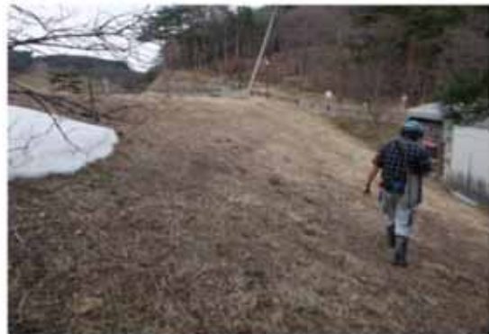
10 決壊しなかった箇所では被害が大きかった堤体の状況（堤外側）
