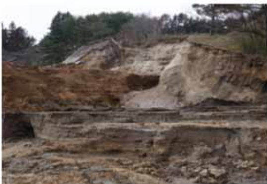
5 左岸側の堤体の状況
