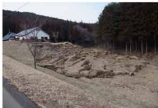
12 周辺施設（三世代交流館）の盛土のすべり
