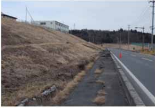
13 工場盛土のすべり（調整池（写真右）方向へのすべり）
