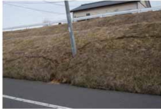
16 住宅団地の盛土のはらみだし
