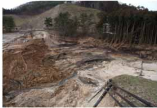
8 堤体右岸側から堤体を見た状況
