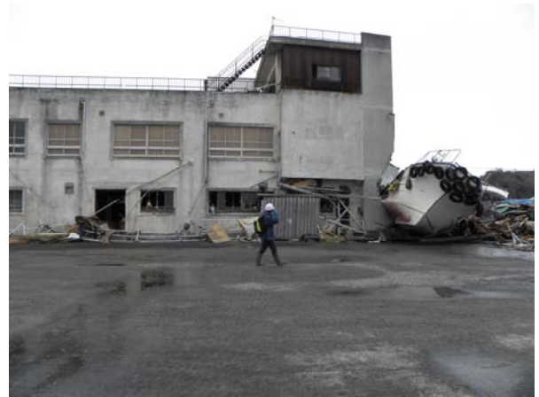
写真-6 鉄骨・RC構造物の損傷状況(その2)
