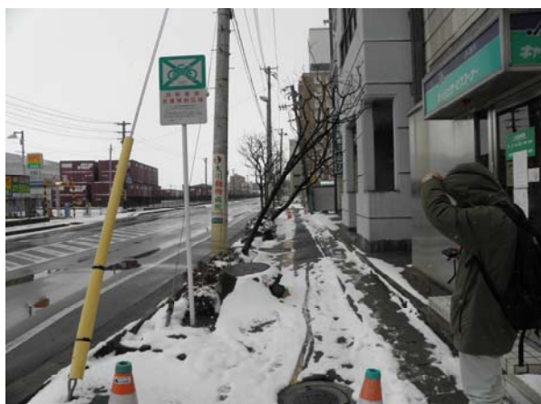
写真-1 マンホールの浮き上がりと街路樹の傾斜
