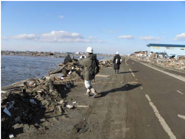
写真-19 荒浜地区の被災状況（その2）
