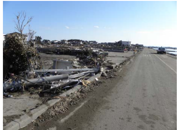
写真-20 荒浜地区の被災状況（その3）
