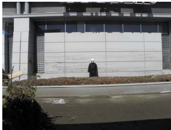
写真-12 ターミナルビルに残された津波の痕跡
