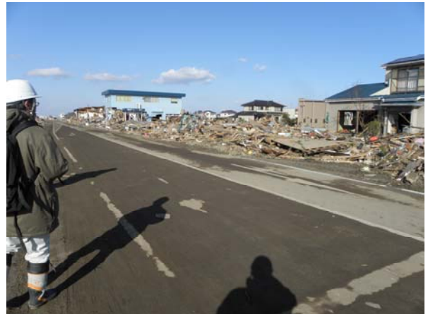
写真-18 荒浜地区の被災状況（その1）
