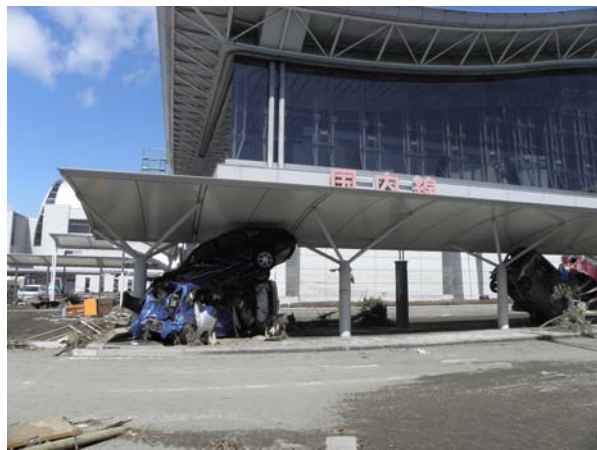
写真-11 空港ターミナルビル横通路に挟まった車
