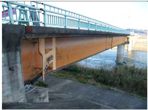
鎌田大橋 全 景
