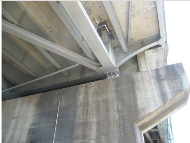
大黒橋 下弦材と端床桁の格点部
