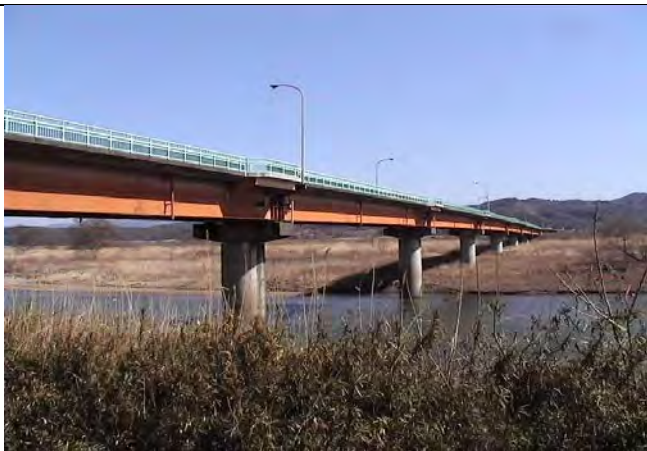
鎌田大橋 全 景
