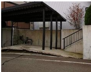
噴砂の力で持上がった土間、住宅は30cm不同沈下
