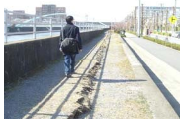
河川護岸(境川)
