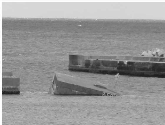
写真1 不同沈下した防波堤ケーソン（相馬港）
