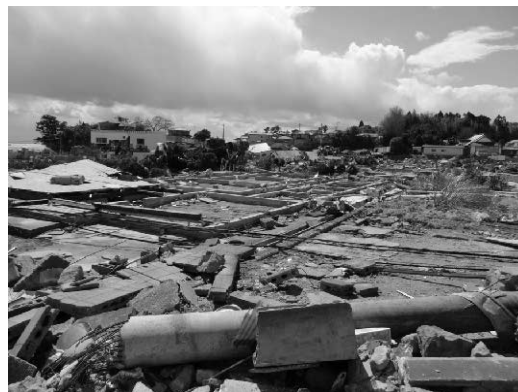
写真 1 木造住宅の被害
