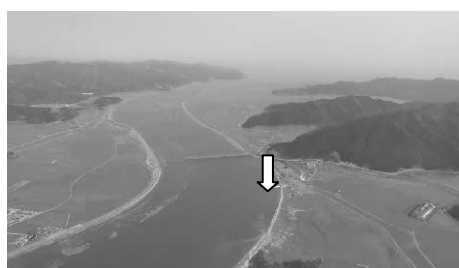
写真 2. 北上川右岸の破堤部(2) (押し波による破堤)
