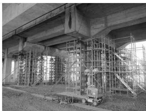
写真2 応急復旧の様子
