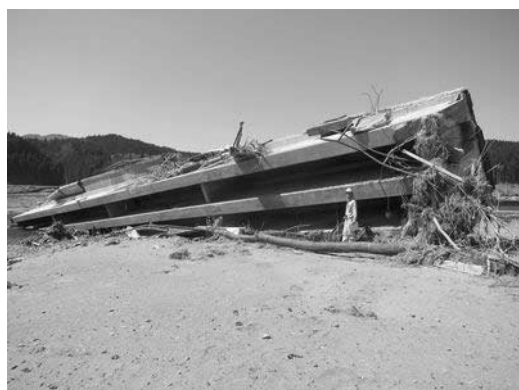
写真3 津谷川橋梁のPC桁の落橋
