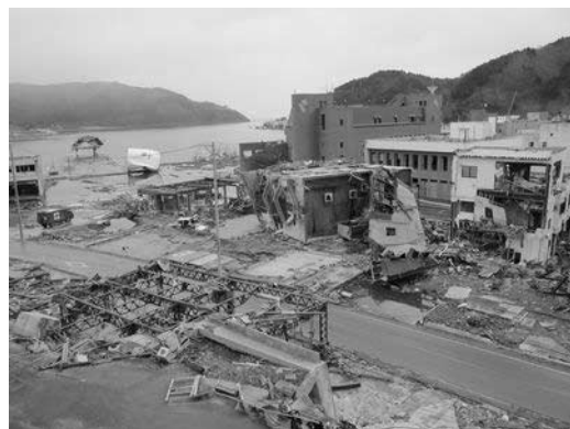
写真 2 RC 建物の倒壊（女川町）
