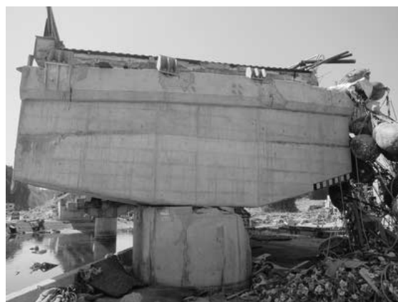
写真 3 歌津大橋の落橋防止装置の破壊
