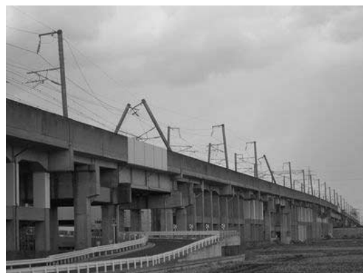
写真 1 東北新幹線の電化柱の損傷
