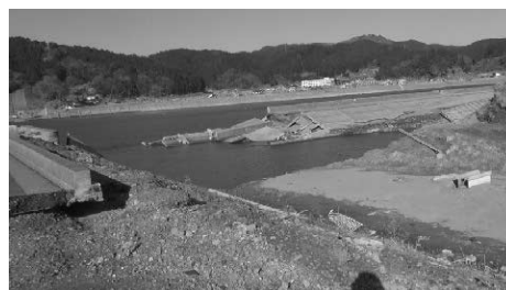
写真 4. 気仙大橋上流側(右岸)の 破堤部(2) (引き波による流亡)
