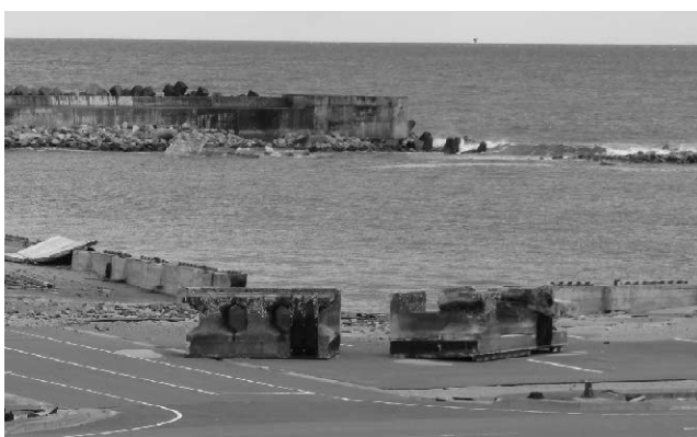
写真2 打ち上げられた護岸ブロック
