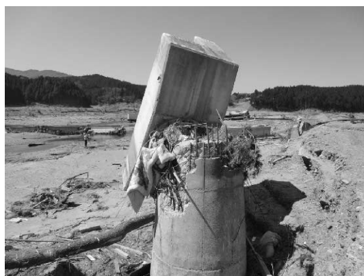
写真4 津谷川橋梁の橋脚の破壊
