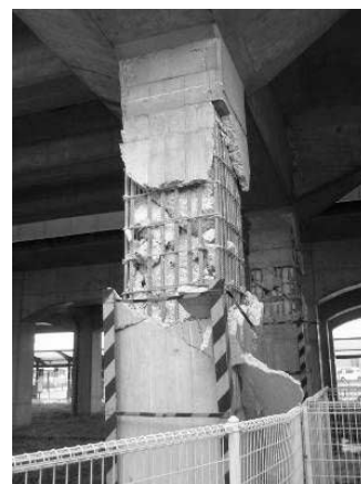
写真1 柱の損傷状況
