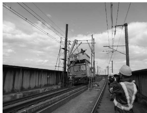
写真2 電化柱の取り替え作業
