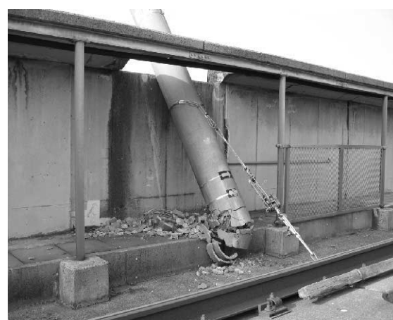
写真 2 電化柱の折損
