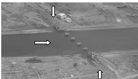
写真 3. 気仙大橋上流側の破堤部(1) (引き波による流亡)
