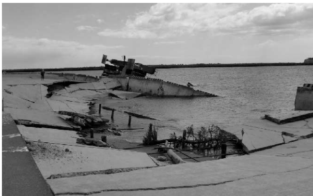
写真1 液状化および津波（引き波）により被災した岸壁（相馬港）
