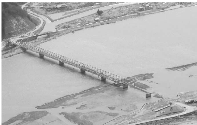
写真 1 トラス橋の流出（北上川）
