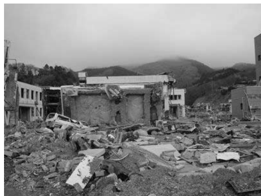
図 3 杭基礎を有する RC 建物の倒壊 （女川町）
