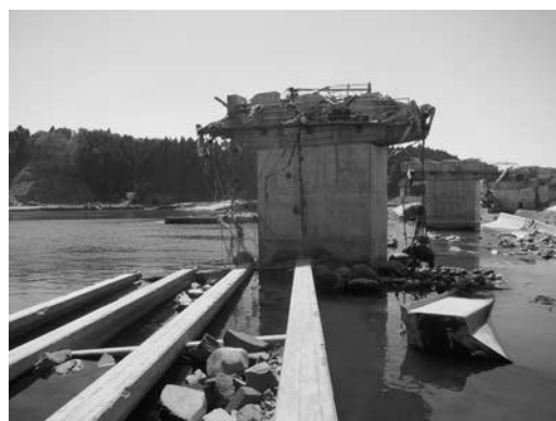
写真2 歌津大橋のPC桁の落橋
