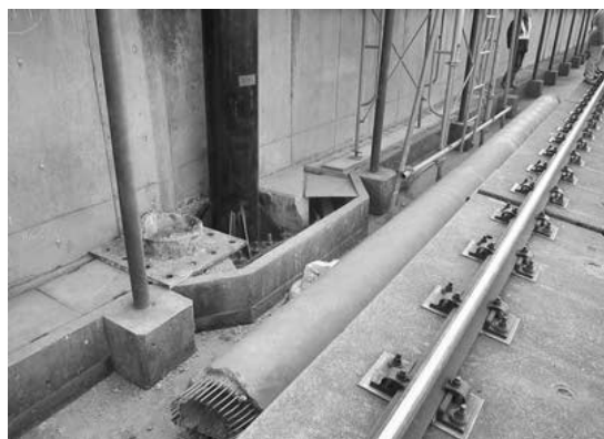
写真1 取り替えられた鋼管の電化柱と、倒壊したコンクリート電化柱が据え付けられていた台座
