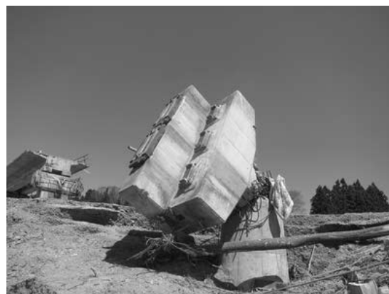
写真 2 津谷川橋梁の橋脚の被害
