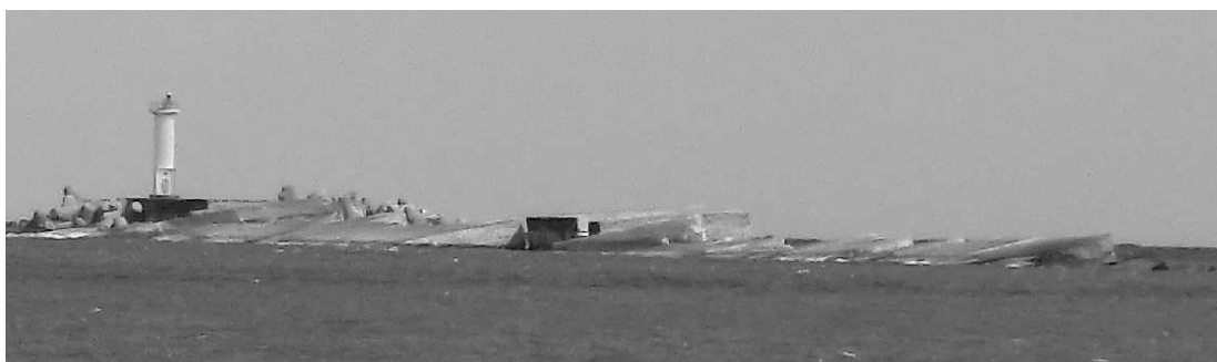
写真3 不同沈下が生じた防波堤
