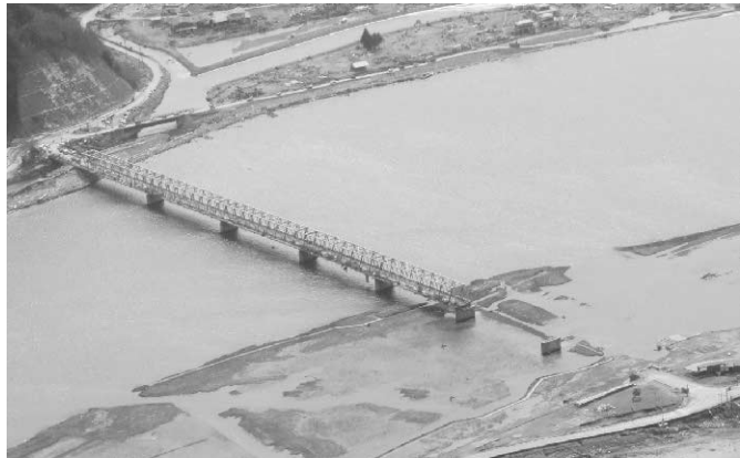
写真 1 トラス橋の流出（北上川）
