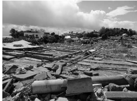
写真 1 木造住宅の被害
