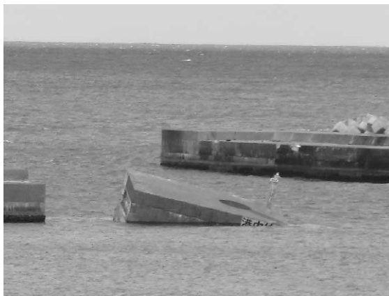
写真1 不同沈下した防波堤ケーソン（相馬港）
