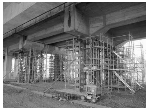
写真 2 応急復旧の様子
