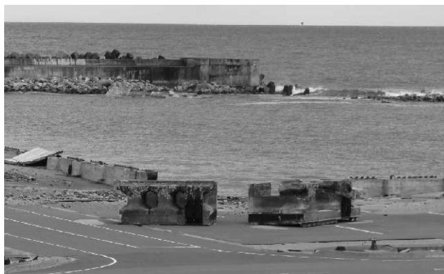
写真 2 打ち上げられた岸壁のケーソン
