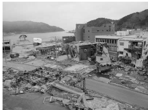
写真 2 RC 建物の倒壊（女川町）
